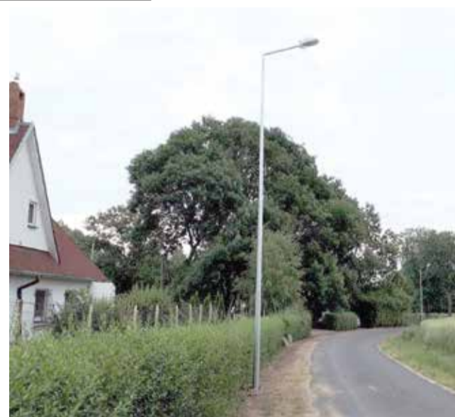
Lampy zamontowane w Starym Szczepankowie. Fot. UMŚ
